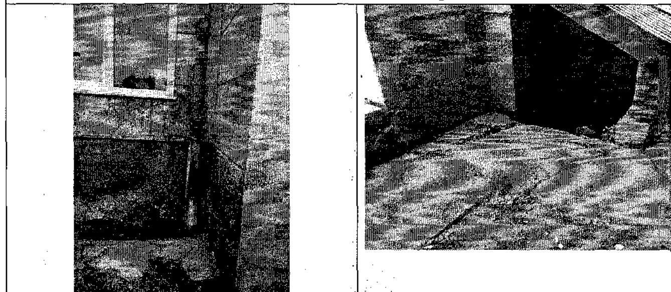
Фото 3,4. Отмостка здания. Локальная утрата и провал отмостки. зазоры между стенами здания и отмосткой шириной до 40 мм.
