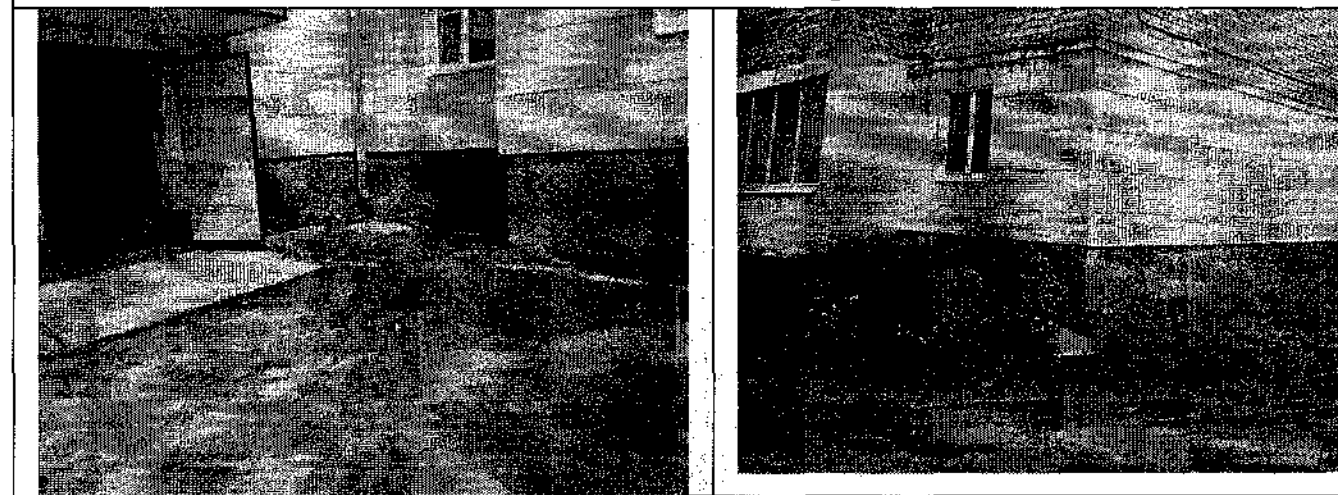
Фото 3,4. Отмостка здания. Локальная утрата и провал отмостки. зазоры между стенами здания и отмосткой шириной до 40 мм.
