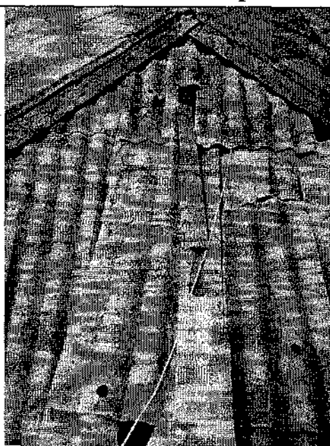
Фото 15. Кровля. Разрушены асбоцементные листы. Утраты шифера.
