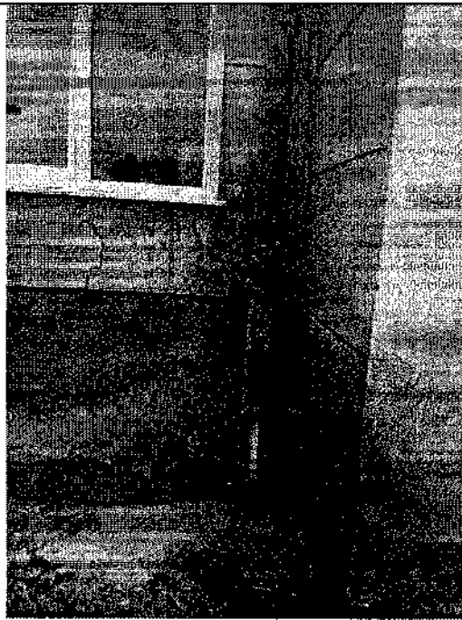
Фото 17,18. Водосточная система. Трубы коррозированы.
